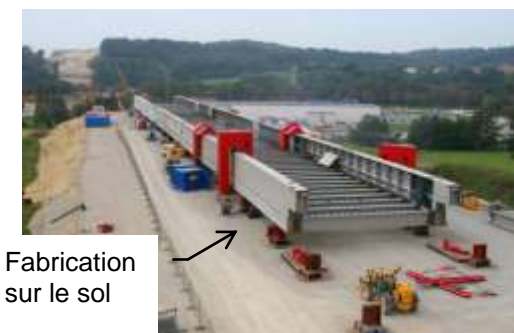
Zone de liaison des travées par soudeure
