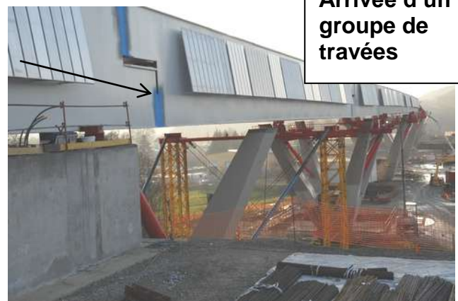
Zone de liaison des travées par soudeure
